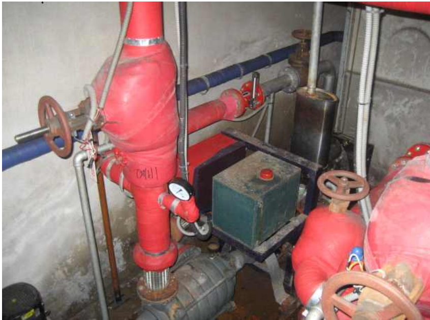
단기통 엔진펌프 (Single Cylinder Diesel Engine) 본 빌딩은 주펌프와 예비펌프가 단기통 엔진펌프이다.
